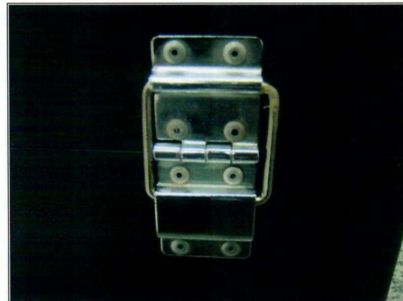
**Figura 14 – Dobradiça de metal com parada de 90° fixada no corpo da mala por rebites**
