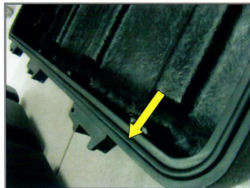
Figura 25 – Detalhe da borracha de vedação
